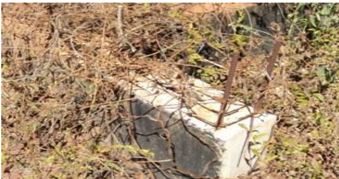
FIGURA06: DETALHE DO ARRANQUE DE PILARETE DA FUNDAÇÃO.
