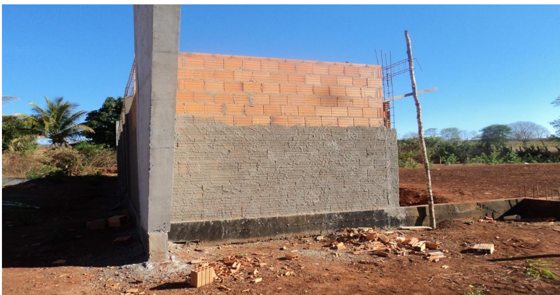
FIGURA02: ALVENARIA DE VEDAÇÃO DO VESTIÁRIO
